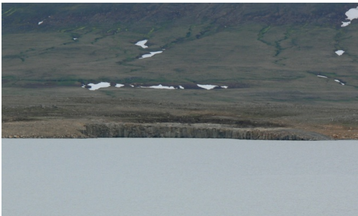
Grjótnáma vestan Ufsarlóns. Reynt var að milda ástýnd námunnar með því að ýta jarðvegi sem haugsettur hafði verið ofan námunnar að brún og jöðrum hennar. (22.06.2010)
