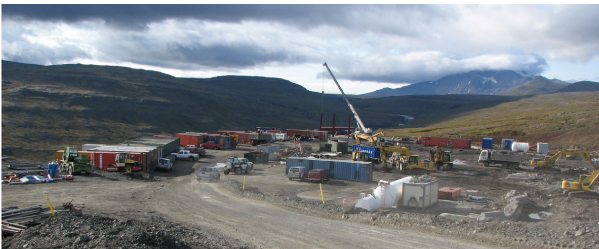
Starfsmenn Impregilo fjarlægja tæki og búnað á athafnasvæði við aðgöng II. Brún plans neðan við rauða gáma til vinstri á myndinni var dregin inn á planið til að mynda aflíðandi brekku neðan vegar í líkingu við óraskað land utan athafnasvæðis.
