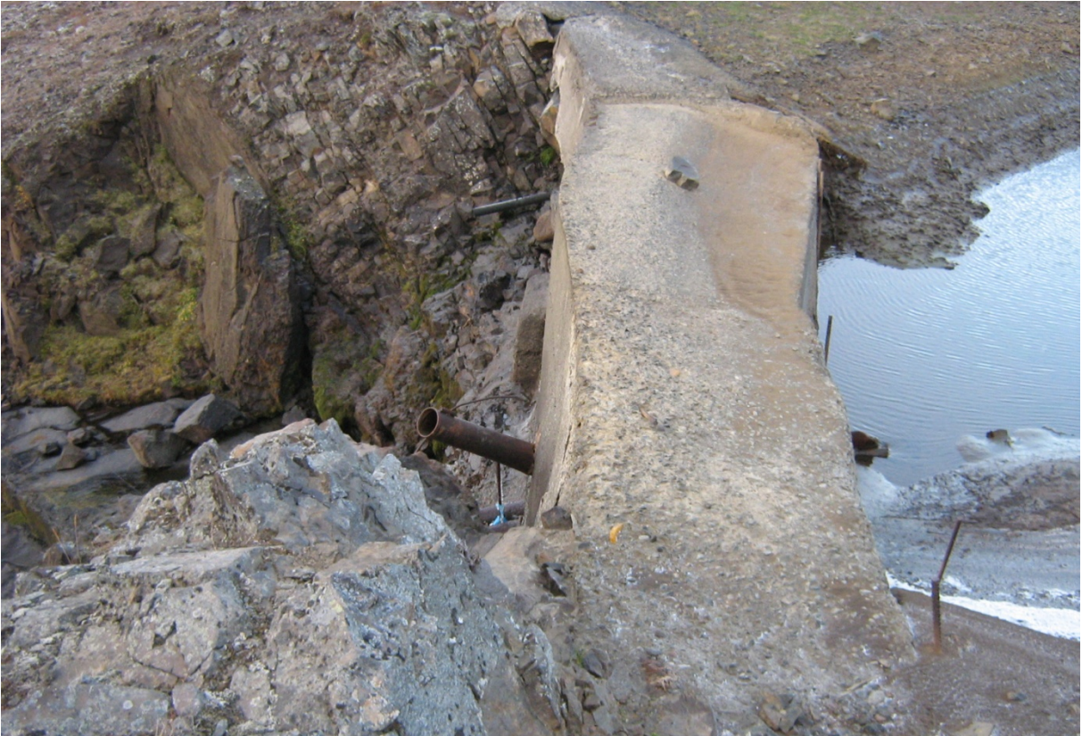
Steypt stífla í Axará neðan vinnubúða. Stíflan var gerð vegna vatnstöku úr ánni. (30.09.2008)
