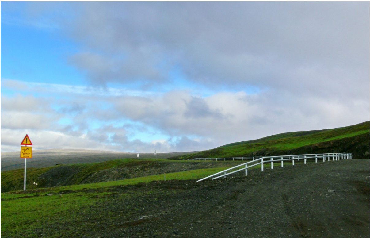
Uppgræðsla skeringar hafin. Þarna var sáð fræblöndu sem í var túnvingull og rýgresi. Markmið uppgræðslu á þessum stað var að binda jarðveg til að hindra úrrennsli, en einnig til að skapa aðstæður fyrir staðargróður til að nema land. (17.09.2010)
