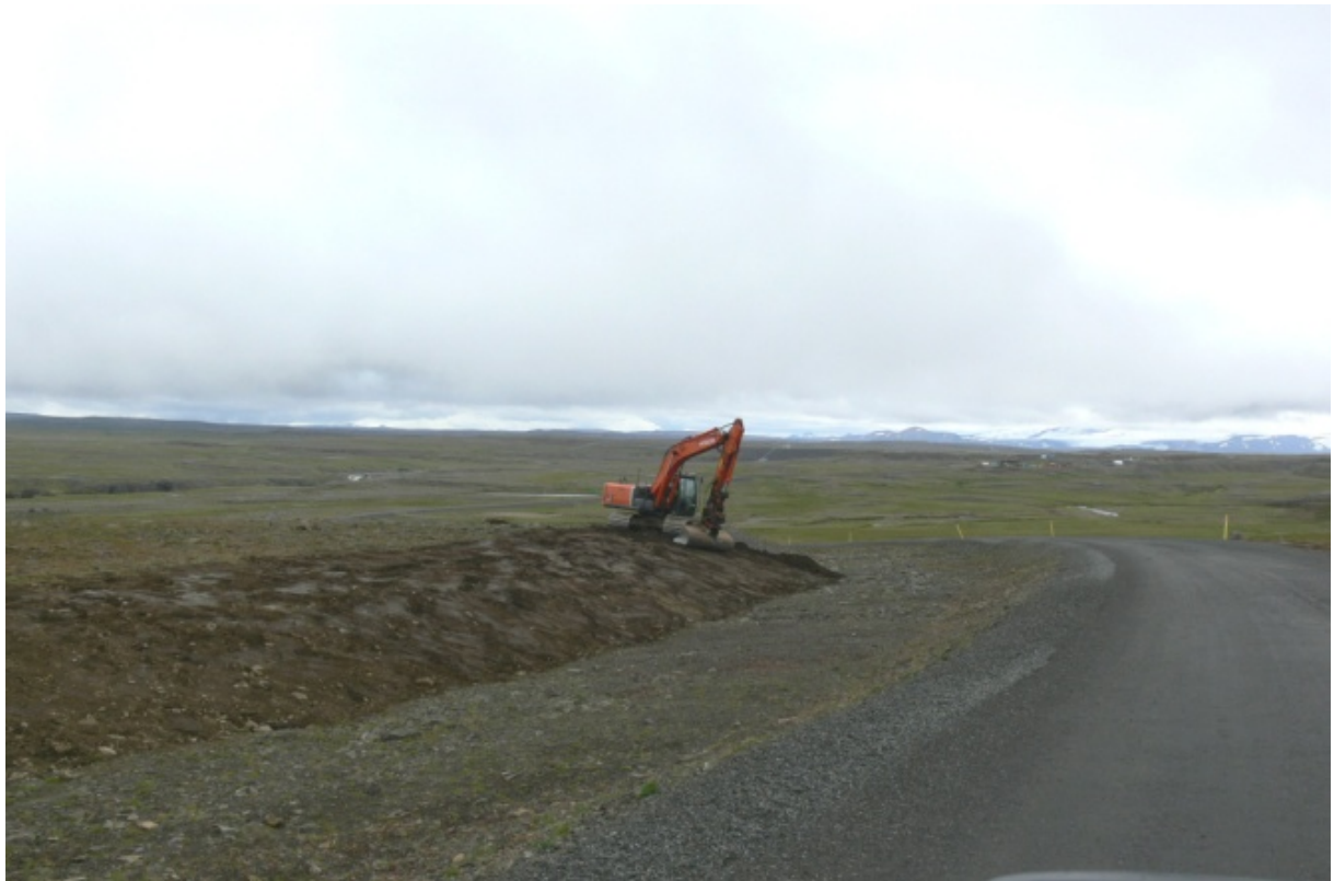
Skering sunnan sveifluganga. Efri brún skeringar var „rúnnuð“ og flött út til samræmis við landform í næsta nágrenni. (17.08.2010)
