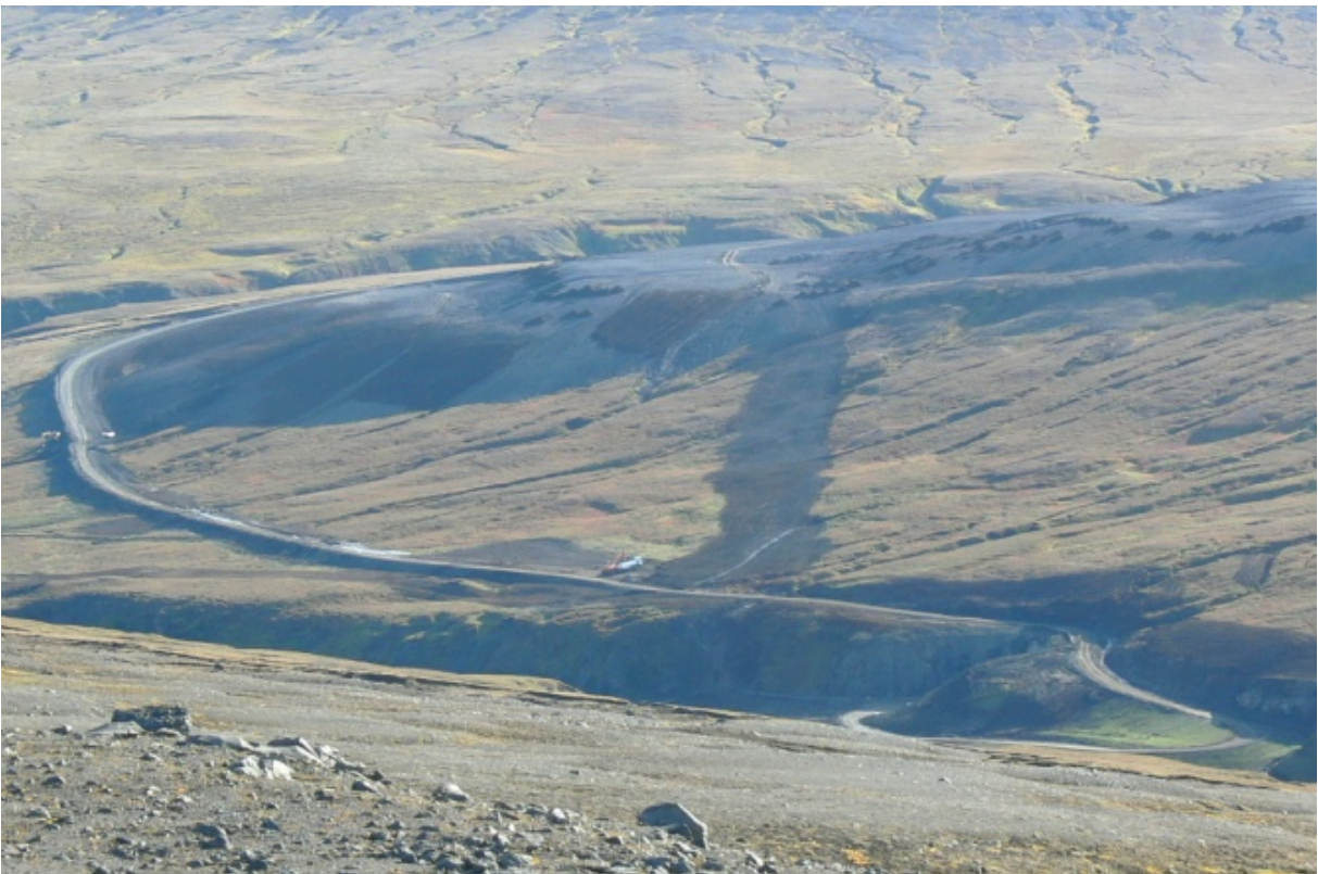
Færíbandaslóð að lokinni landmótun. (10.09.2009)
