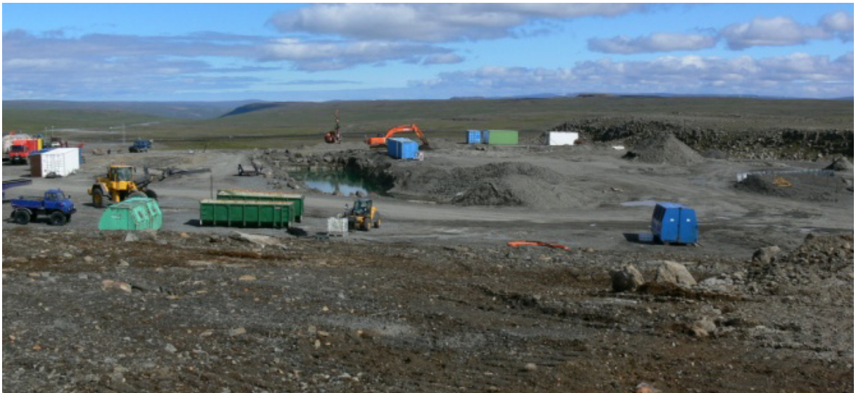
Athafnasvæði séð úr suðri. Búið að fjarlægja mannvirki. Á þessu svæði var lögð áhersla á að móta skeifulaga brekku sunnan við athafnasvæði þaðan sem myndin er tekin. Mikið efni var flutt inná planið. Lágir hryggir voru mótaðir á planinu. (05.08.2010)
