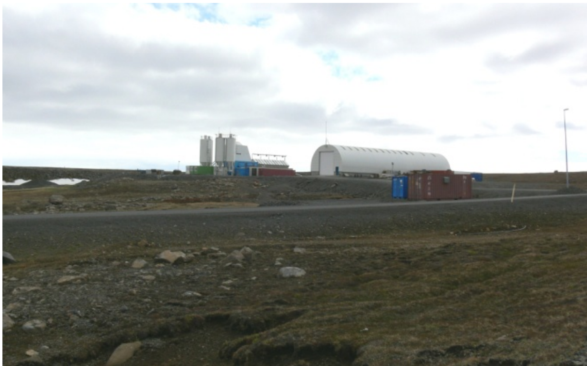
Steypustöð og verkstæðisskemma á steypum undirstöðum. (07.06.2010)
