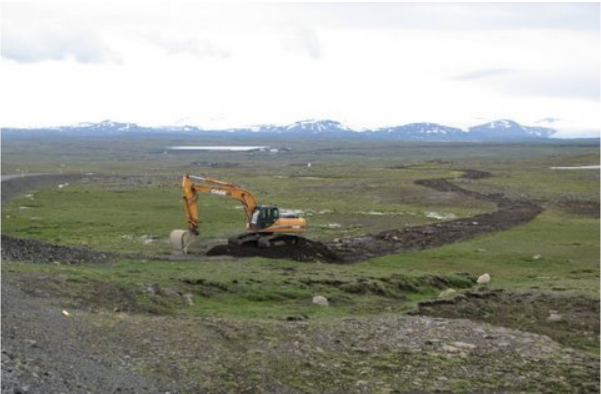
Aflagður vegur nærri Hafursá. Gengið var frá námu með efni úr veginum. Fyrirhugað er að bera tilbúinn áburð á vegsvæði til að flýta gróðurframvindu.
