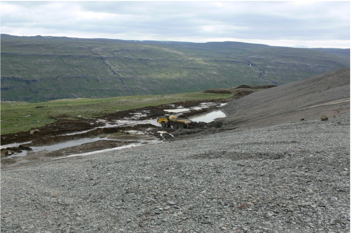
Efni úr vinnuslóðum og mold flutt að frambrún haugs. (06.07.2009)
