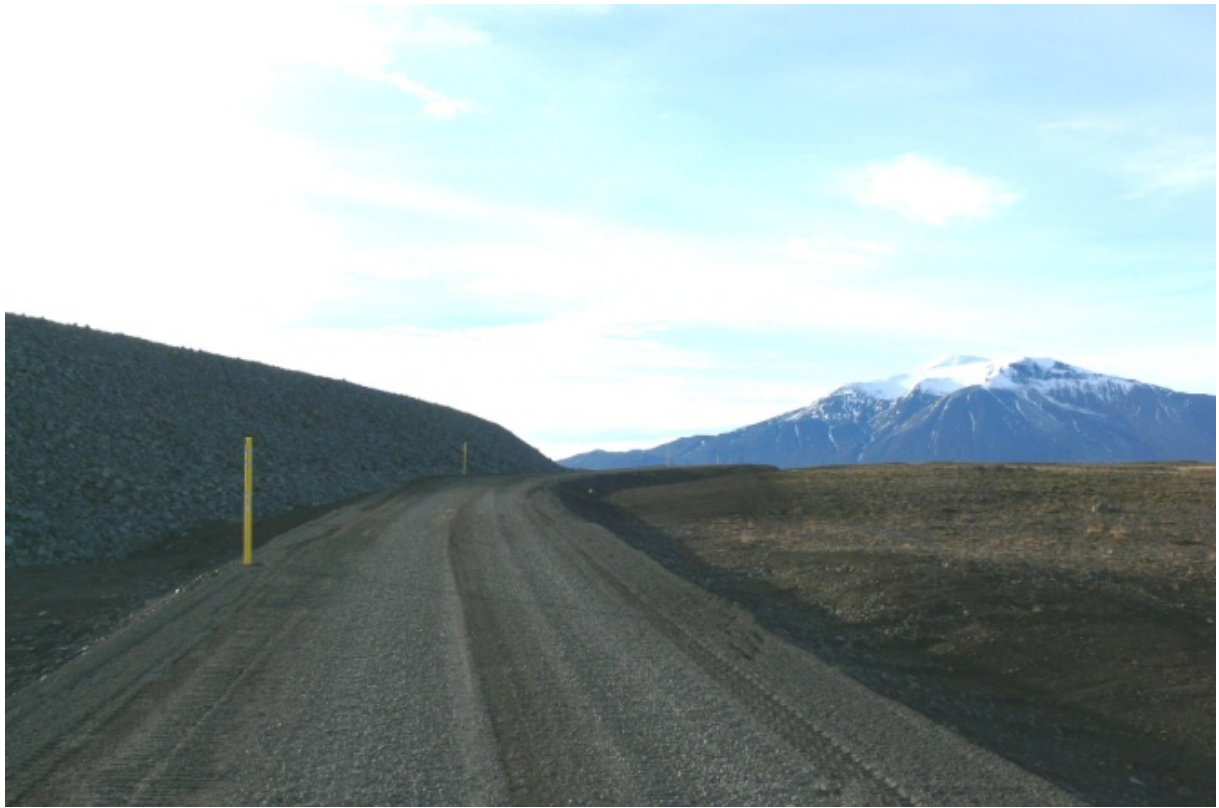
Aðkomuvegur við Kelduárstíflu. Frágengnar skeringar. (10.2010)
