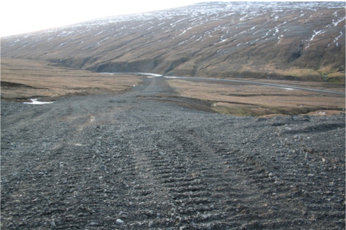
Færibandaslóð þegar steiptar undirstöður hafa verið fjarlægðar sem og hluti efnis úr slóðinni. (07.10.2004)
