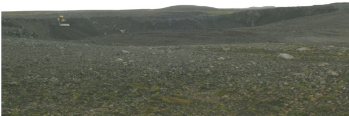
Við frágang námunnar var lögð áhersla á að móta jaðra námunnar með sama halla og „rúnnuðum“ formum sem sjá má í næsta nágreppi námunnar. (25.08.2010)
