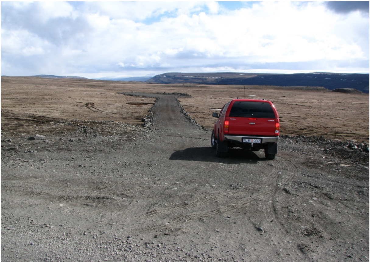
Vegslóð og borplan neðan vinnubúða, norðan vegar. Ekki var talið unnt að koma þessu efni ásættanlega fyrir við planið. Efni var mokað á vörubíla og það nýtt að hluta til frágangs yfir siturlagnir neðan vinnubúða. (22.05.2007)
