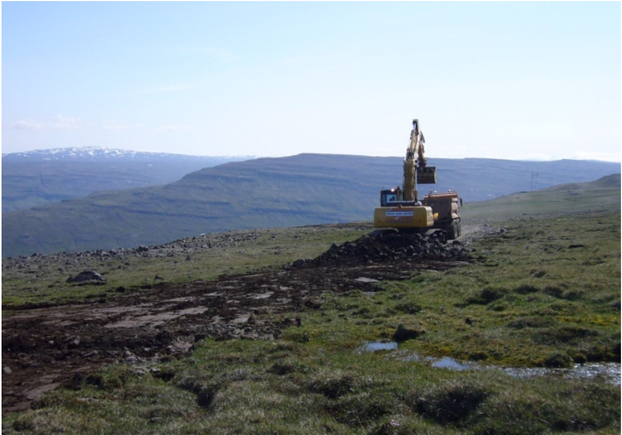
Plani og vegi var mokað á bíla og efnið nýtt til frágangs neðan vinnubúðasvæðis þar sem rotþrær og siturlagnir höfðu verið. (07.07.2009)
