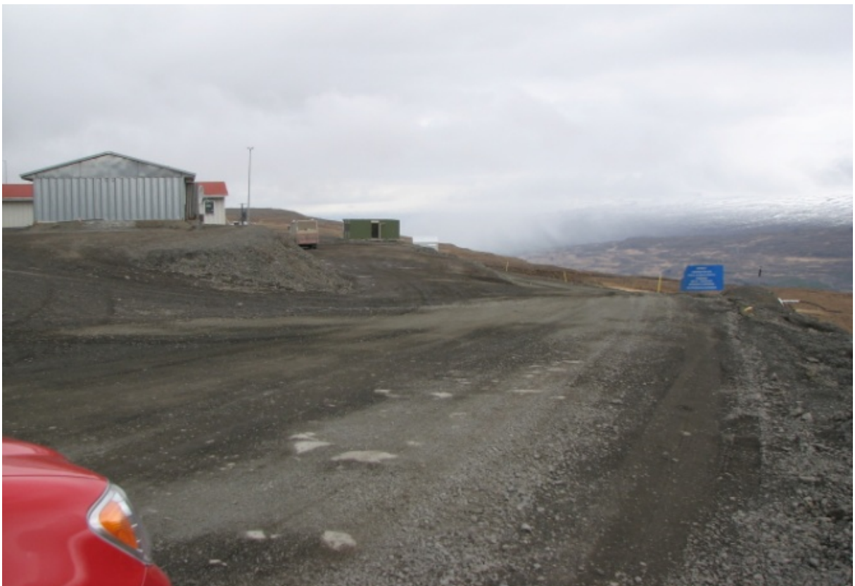
Neðri (Suður) hluti vinnubúða. Aðkomuvegur I var færður ofar á búðasvæðið, á stallinn fyrir miðri mynd. Með því að færa veginn var unnt að koma meira umfræfni fyrir neðan vegar auk þess sem auðveldara var að fella búðasvæðið betur að óröskuðu landi utan þess. (09.05.2007)
