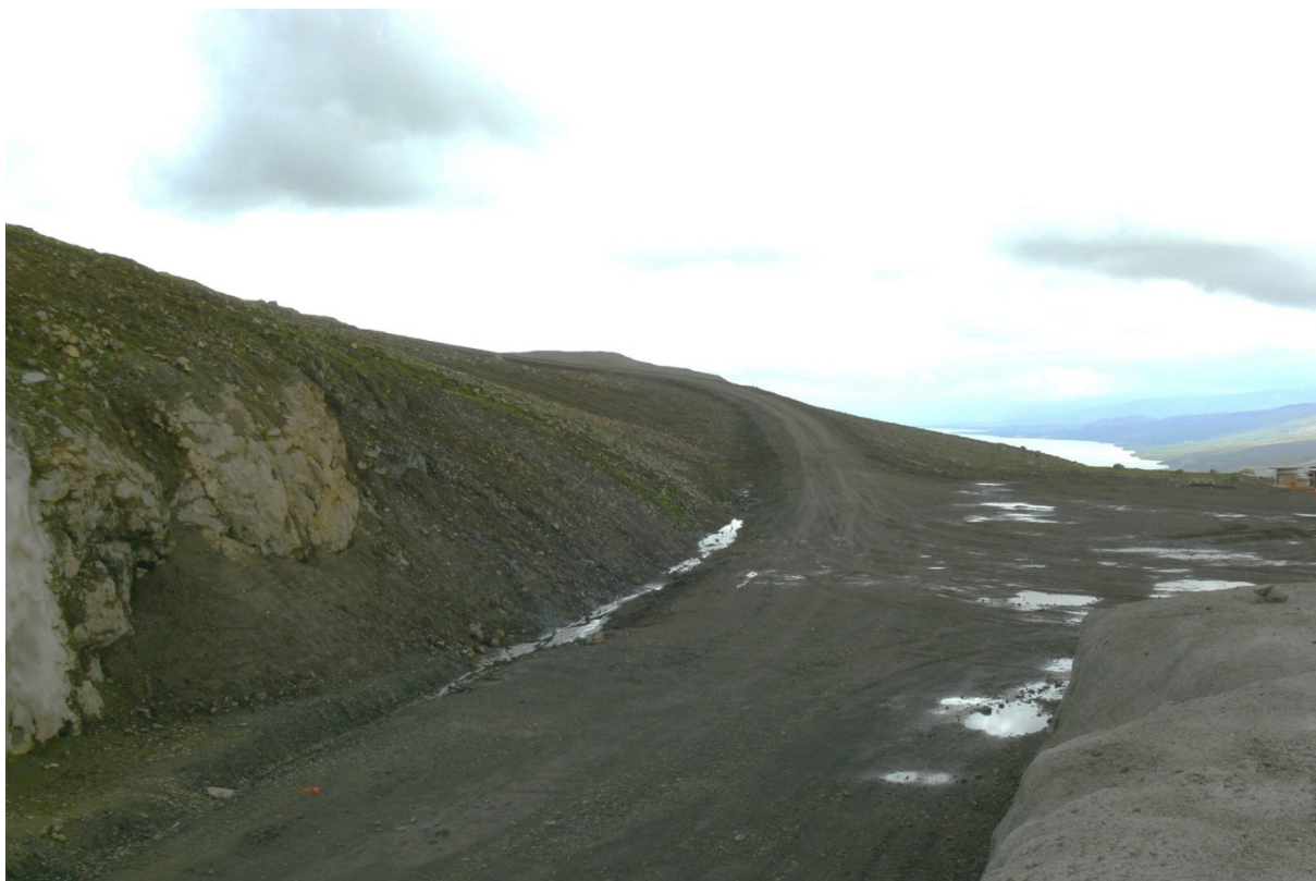
Landmótun lokið. Svæðið verður grætt upp.
