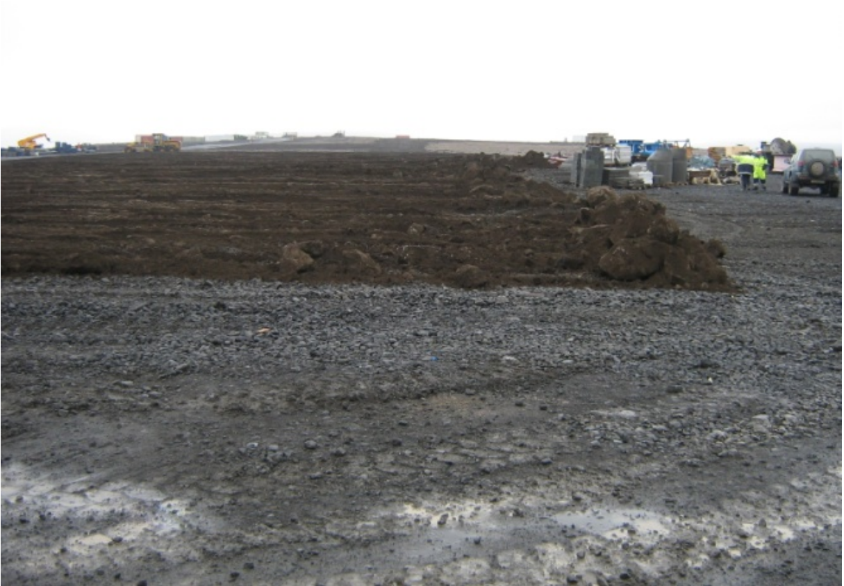
Unnið við að jafna ofanafýtingu yfir athafnasvæði verktaka austan við verkstæði Impregilo. Lögð var áhersla á að dreifa stórgrýti yfir svæðið. (02.08.2008)
