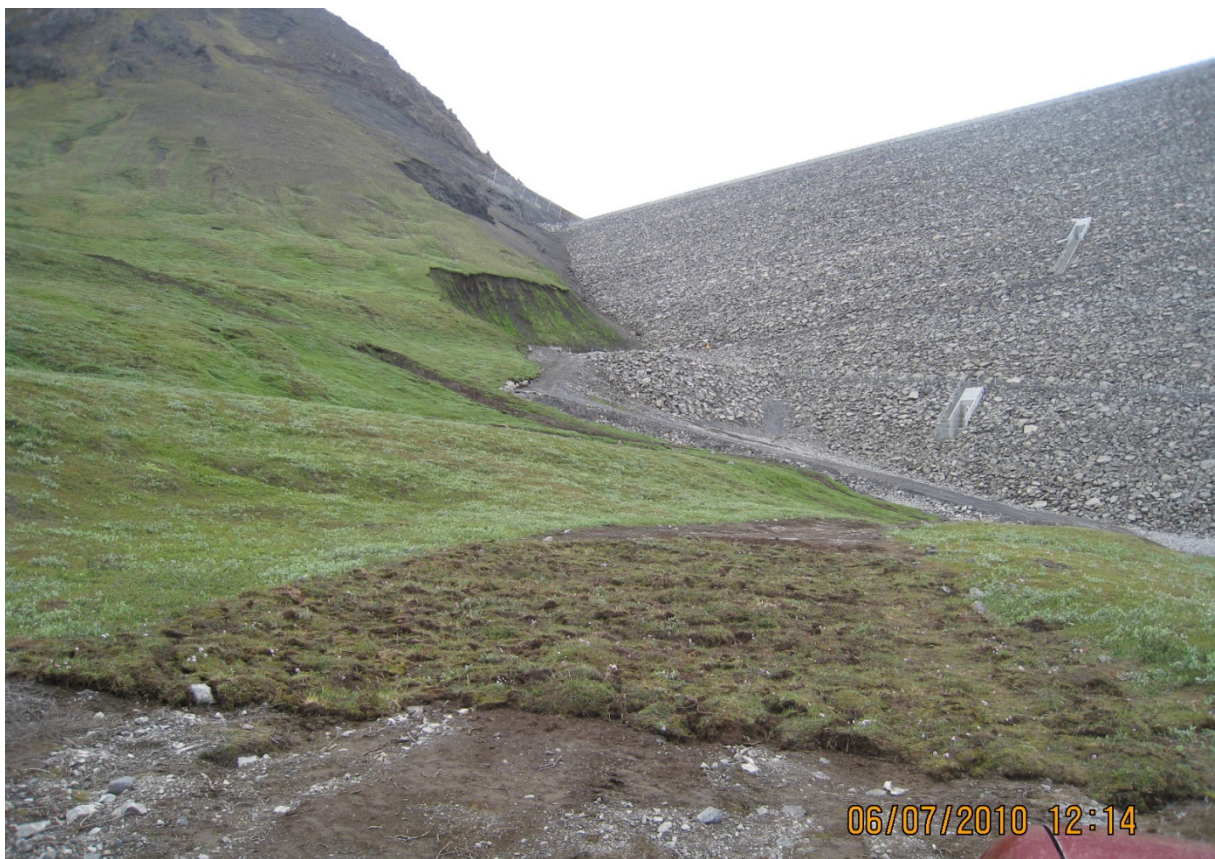
Í lok júní 2010 var sáð í veginn áburði og fræblöndu, sem valin var eftir leiðbeiningum frá starfsmanni Landgræðslunnar. Úthagatorf var sótt í lónstæði Háslóns og lagt niður með höndum eins og sést á mynd á tvo 20 metra kafla. (06.07.2010)
