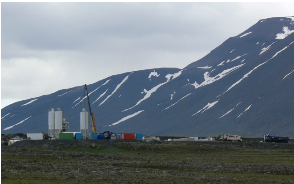
Unnið við að taka steypustöð í sundur. Gengið var síðast frá athafnasvæðinu. Því þurfti að koma þarna fyrir umframefni sem til féll við frágang annars staðar. Lögð var áhersla á að hreinsa frambrún plans ofan af klöppum sem standa fram úr brúninni og móta aflíðandi brekku inn á svæðið fyrir aftan steypustöðina. (09.09.2010)
