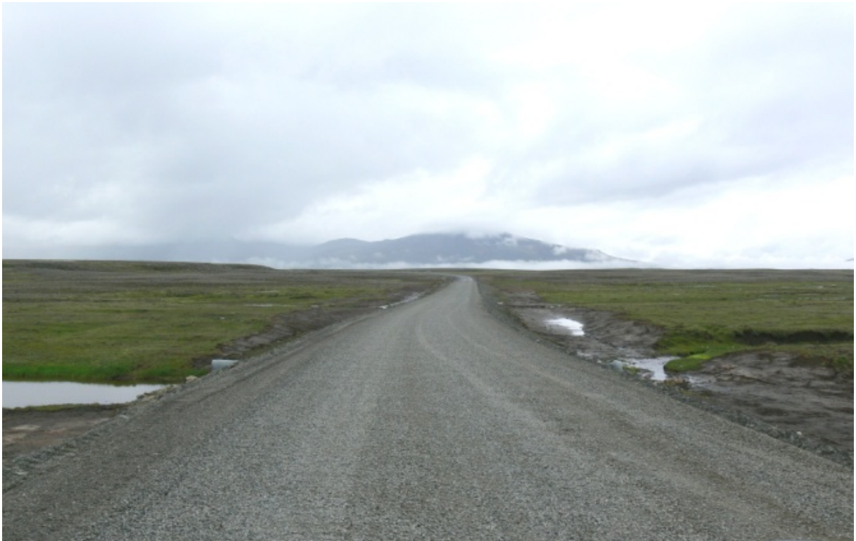
Aðkomuvegur milli Ufsarstíflu og Kelduárstíflu. Lögð var áhersla á að móta skeringar eins flatar og kostur var til að fella þær betur að landi. (28.07.2010)
