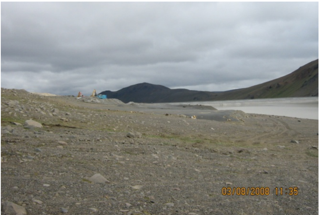
Unnið við að rífa steypustöð. (03.08.2008)
