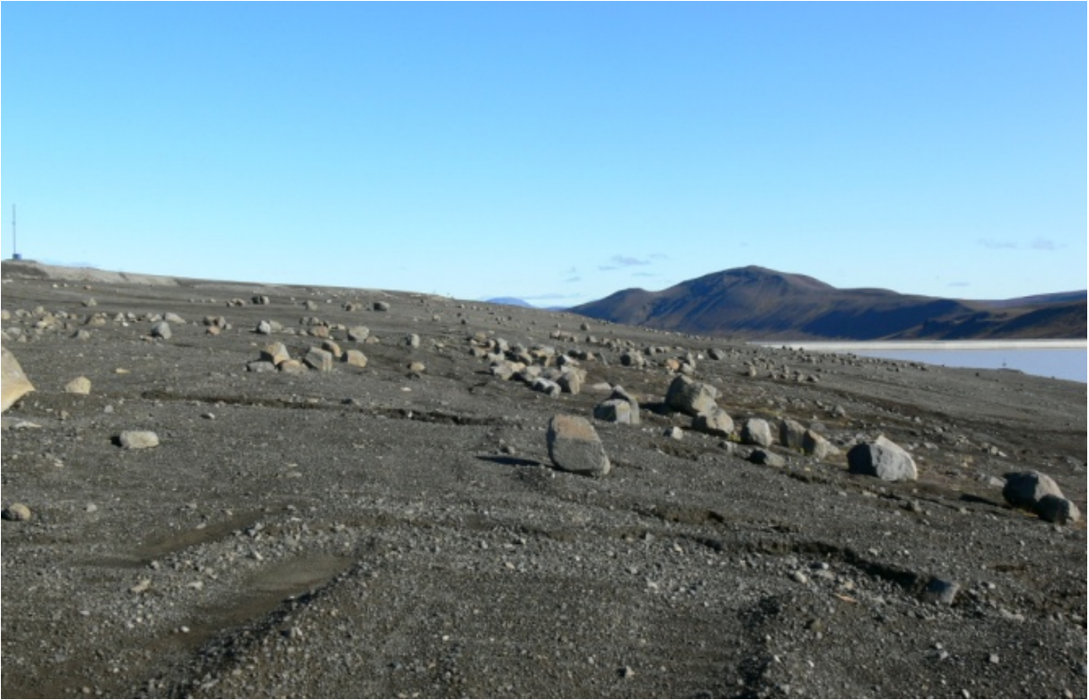
Steypustöðvarsvæði að frágangi loknum. Lögð var áhersla á að dreifa stórgrýti með ofanafýtingu til að ásýnd svæðisins líktist sem mest aðliggjandi svæðum. (09.09.2009)
