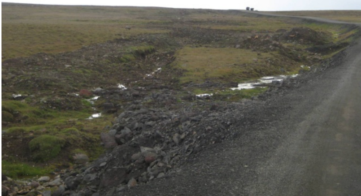
Aðkomuvegur í austan Garðavatns. Þarna er land mjög blautt og talsvert úrrennsli vegna vatnslagnar sem lögð var í skurði frá borholum við Garðavatn að athafnarsvæðum verktaka. (22.03.2011)
