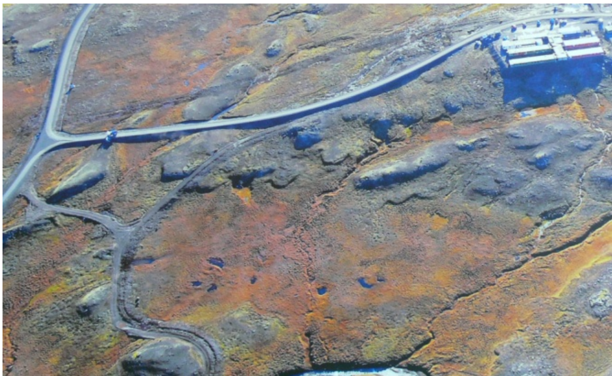
Vegir að vinnubúðum við Ufsarstiflu. Fremst á myndinni er eldri vegur sem var fjarlægður. Efni úr veginum var mokað upp og því ýmist ekið burt eða notað til frágangs á skeringum og námum. (10.08.2010)
