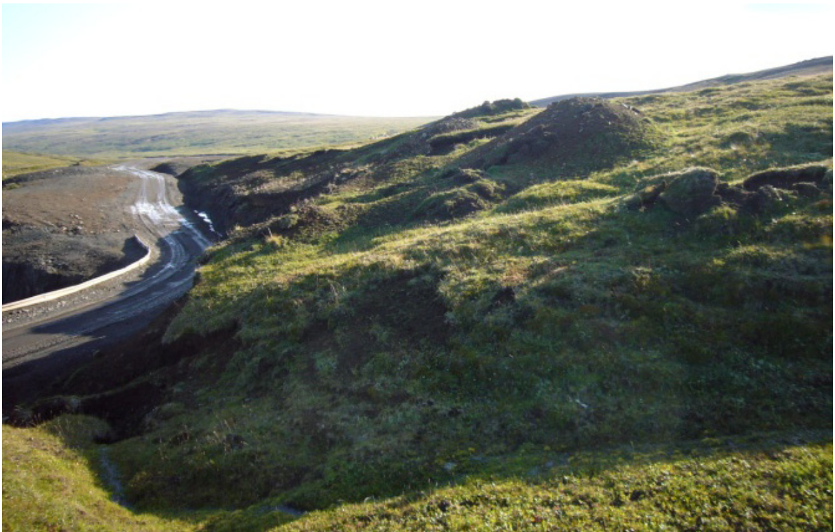
Vegskering ofan gangnamunna. Þessi skering var tekin í þykkan moldarkenndan jarðveg. Þarna var talsvert úrrennsli. Nauðsynlegt var að móta skeringuna að nýju til að tryggja uppgræðslu og að skeringin hefði sem líkasta lögun og halla og óraskað land. (20.08.2009)
