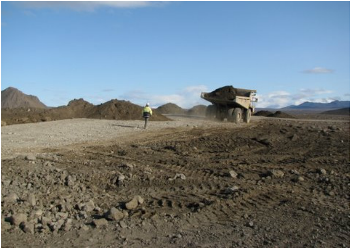
Reynt var að móta búðasvæði þannig að ekki mynduðust samfelldir sléttir fletir. Talsvert magn af ofanafýtingu var notað til frágangs á búðasvæðum. (15.09.2008)
