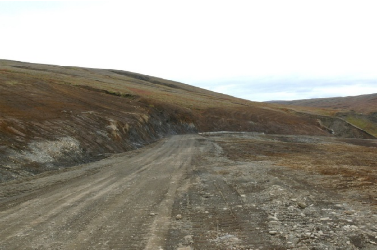
Mótun skeringar lokið. (21.09.2009)
