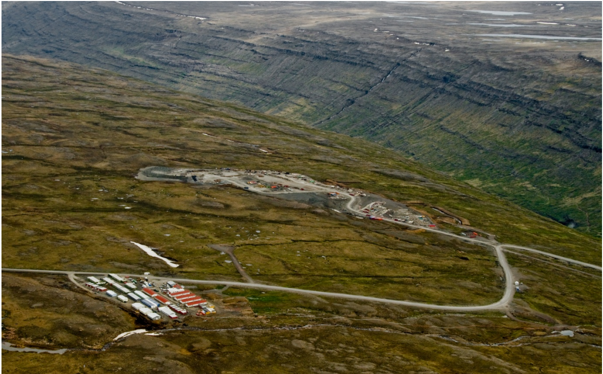
Búðasvæði og haugsvæði. Myndin tekin meðan á framkvæmdum stóð. (25.06.2008)
