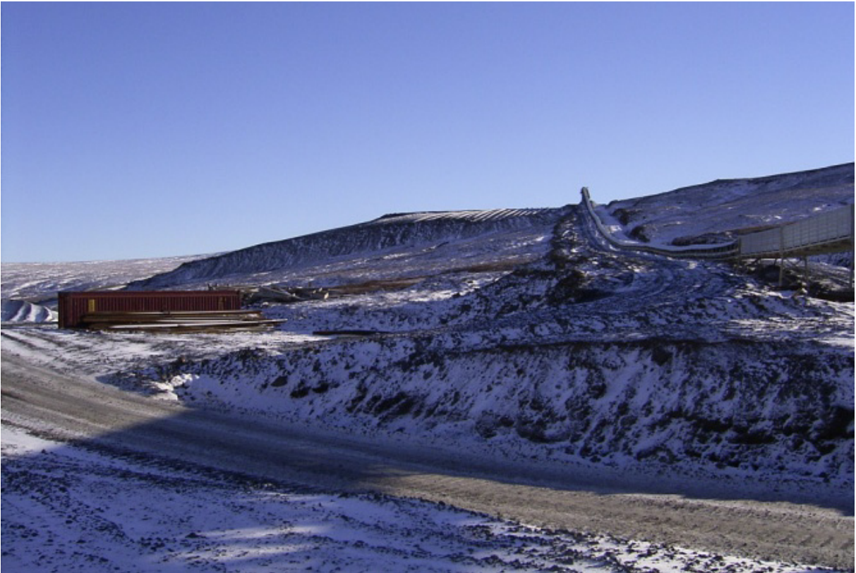
Færibandaslóð að haugsvæði ofan gangnamunna. Færibandið stóð á steiptum undirstöðum. Meðfram færibandinu var lögð slóð sem nýtt var við samsetningu og niðurrif færibandsins. (08.10.2008)
