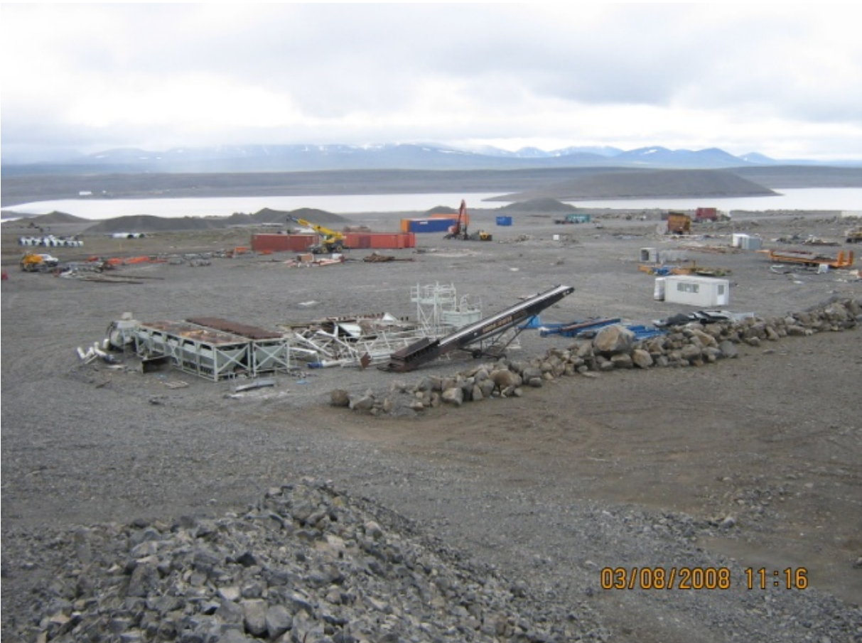
Athafnasvæði verktaka vestan steypustöðvar. (03.08.2008)
