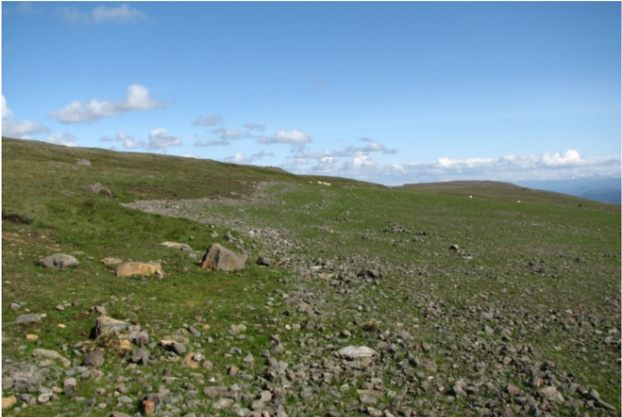
Efri hluti búðasvæðis að lokinni landmótun og sáningu. Við frágang búðasvæðisins var lögð áhersla á að fylgja eins og kostur væri hæð og lögun lands utan þess. Hér hefði mátt flytja meiri jarðveg að búðasvæði til að auðvelda landnám grenndargróðurs. (06.08.2010)
