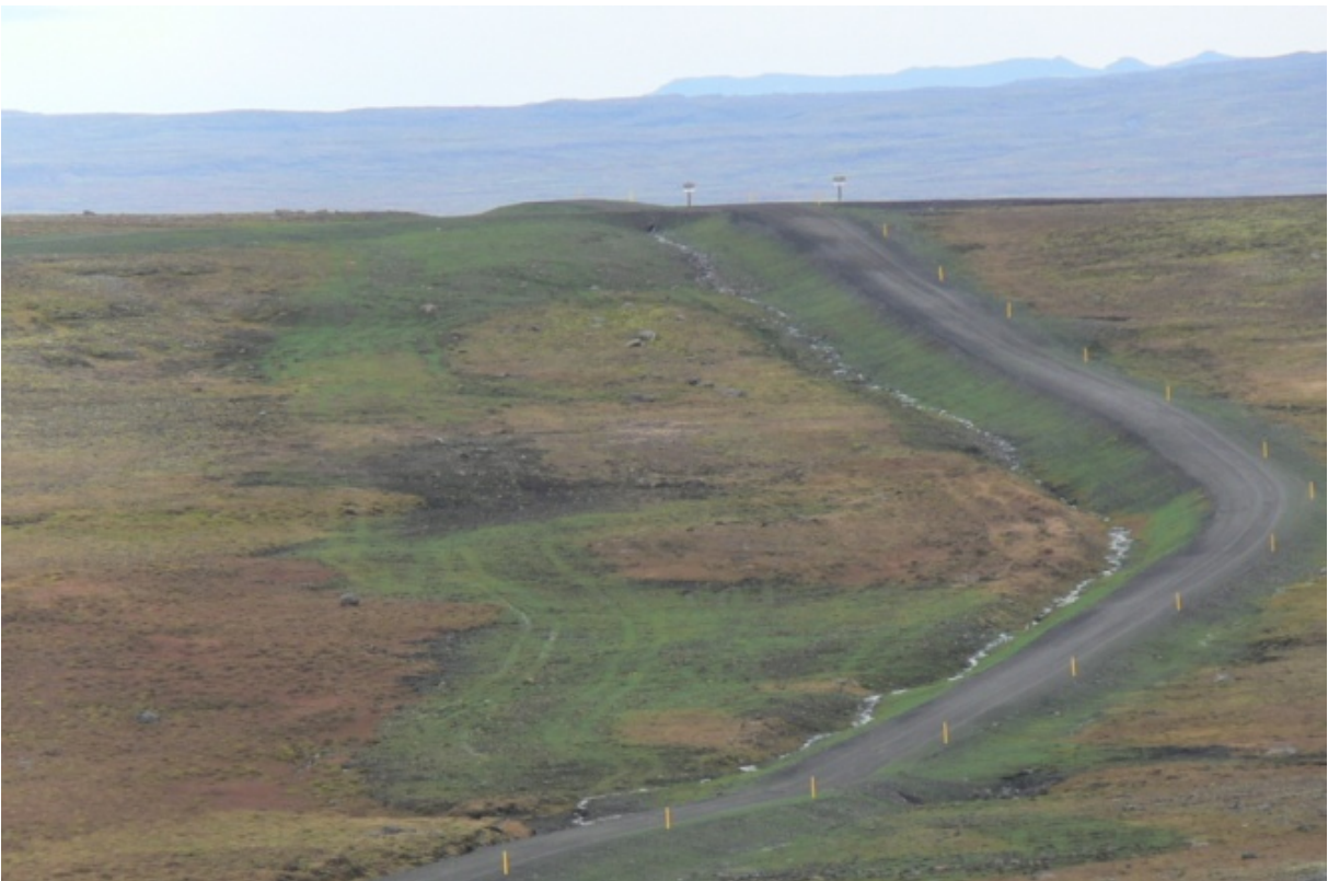
Skurður og vegsvæði að lokinni sáningu. (08.10.2010)
