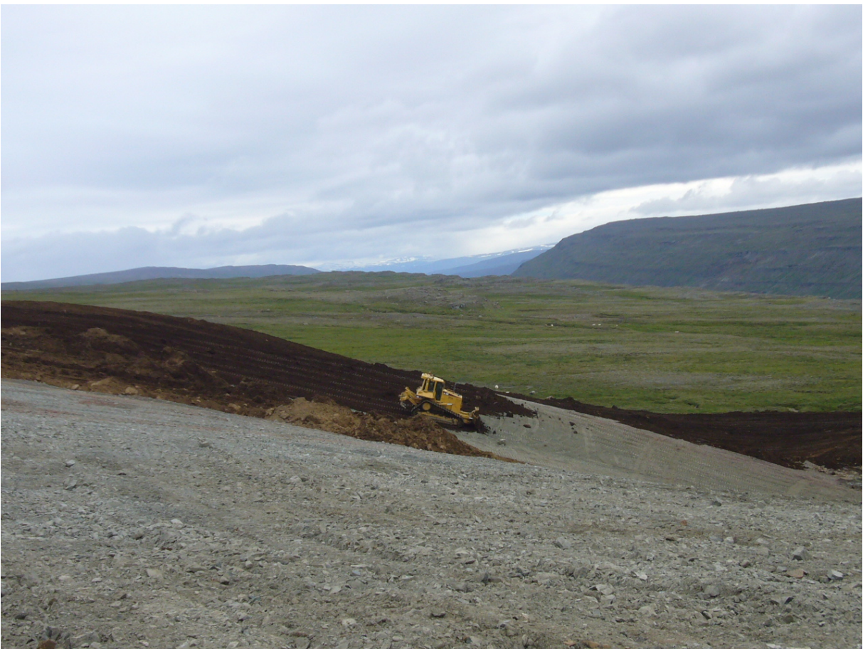
Mold jafnað yfir haugsvæði. (23.07.2009)
