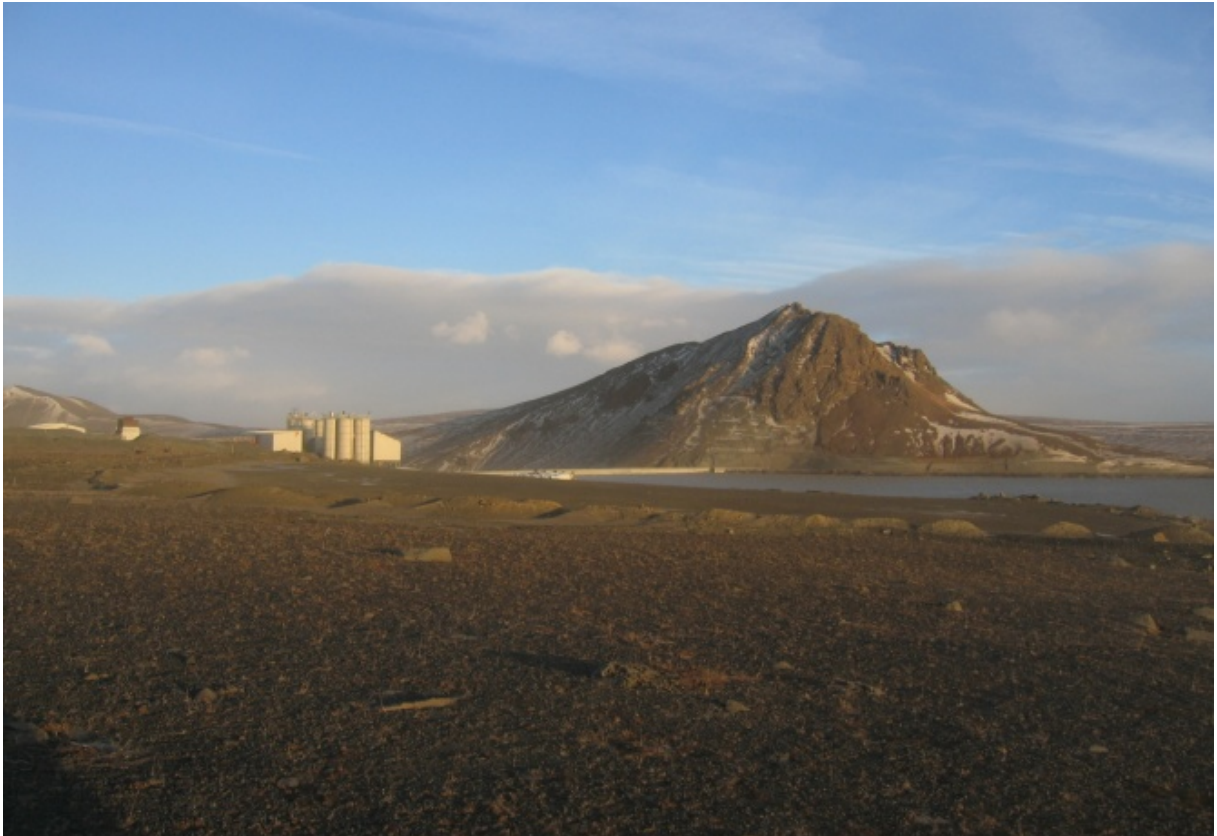
Steypustöð var skammt sunnan Kárahnjúkastiflu milli aðkomuvegar og lóns. (05.11.2007)
