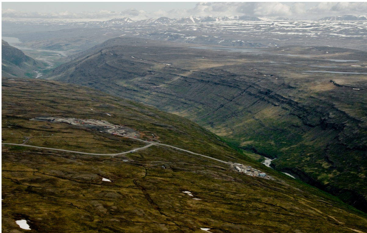
Haugsvæði og athafnasvæði við gangnamunna. Myndin tekin meðan á framkvæmdum stóð. (25.06.2008)
