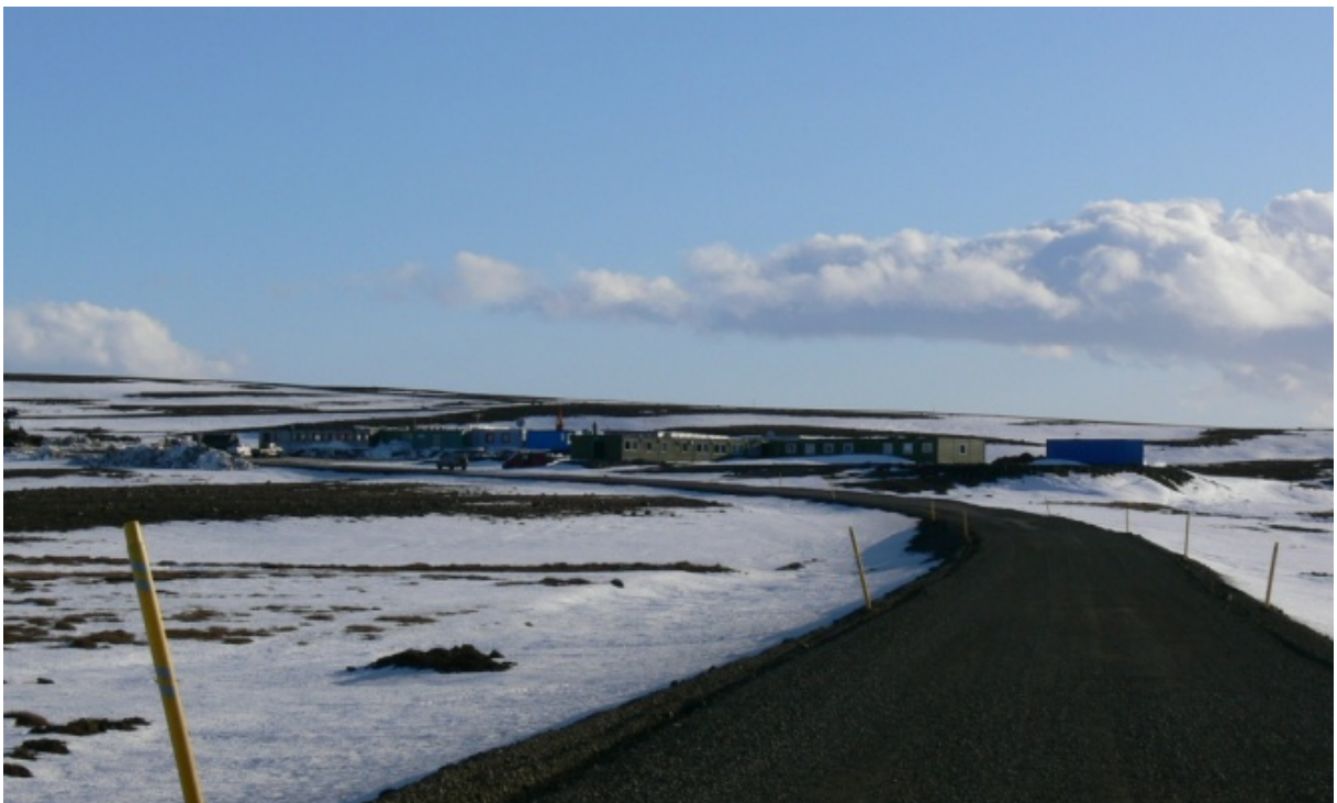
Vinnubúðir Arnarfells vestan Grjótarstíflu. Áður en landmótun hófst á búðasvæðinu voru allar lagnir grafnar upp og fjarlægðar. (10.2009)
