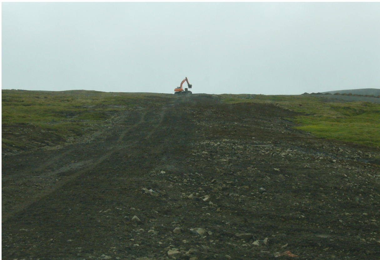
Vegurinn að frágangi loknum. (25.06.2009)
