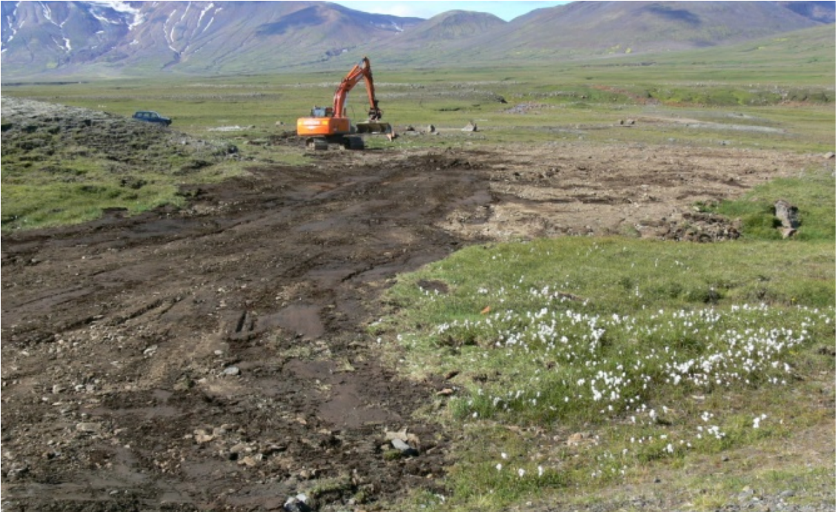
Búið að fjarlægja veltengingu eldri vegar og aðkomuvegar. Umframefni nýttist að hluta til frágangs lítillar námu. (09.08.2010)
