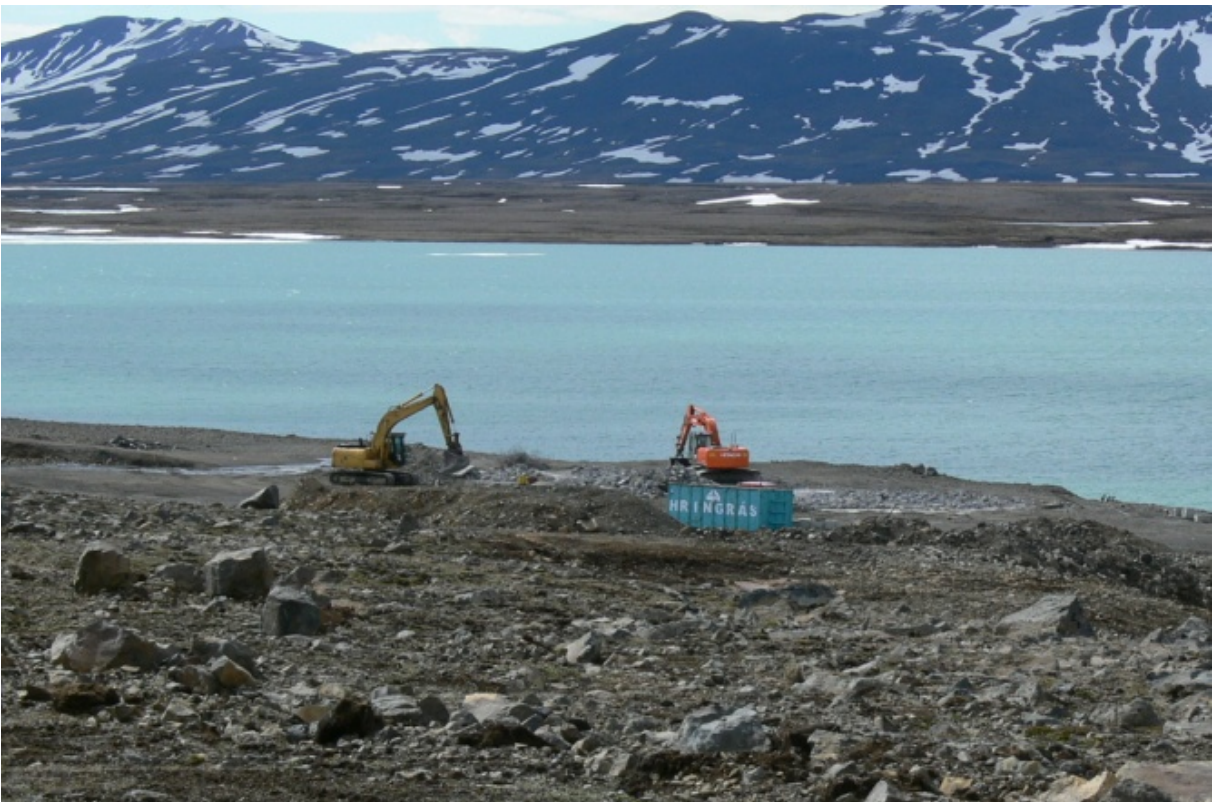
Búið að fjarlægja byggingar. Steypar plötur voru brotnar, steypustyrktarjárn var fjarlægt til endurvinnslu og steypubrot urðuð í námu skammt sunnan verkstæðis. Vegur frá verkstæði að aðkomuvegi var fjarlægður og efnið úr honum notað til urðunar á steypu. (10.06.2010)
