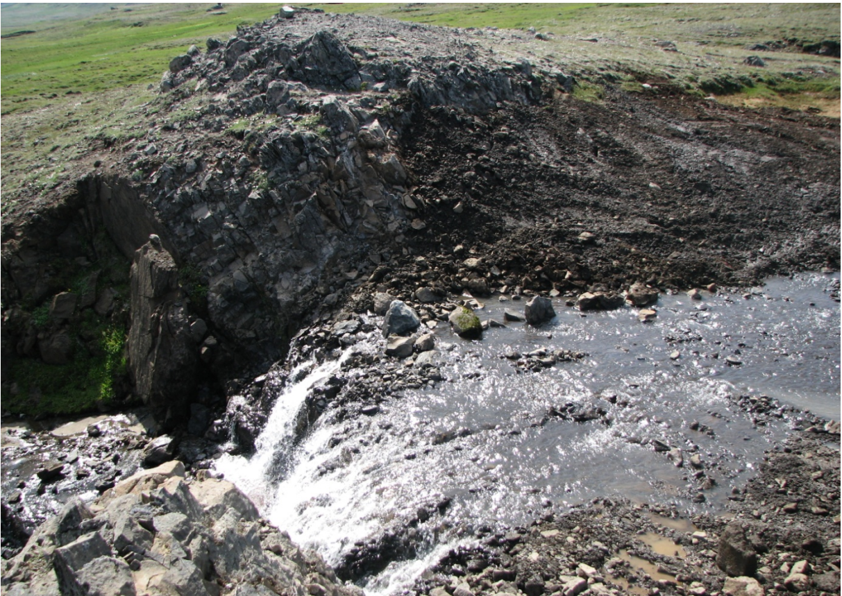
Stíflustæði að loknum frágangi. (08.07.2009)
