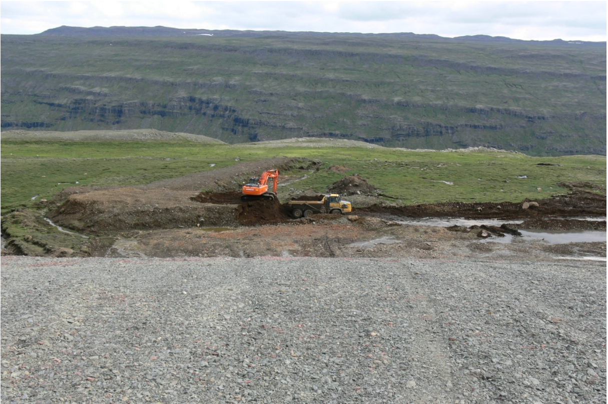
Flutningar á mold til frágangs á yfirborði. (06.07.2009)
