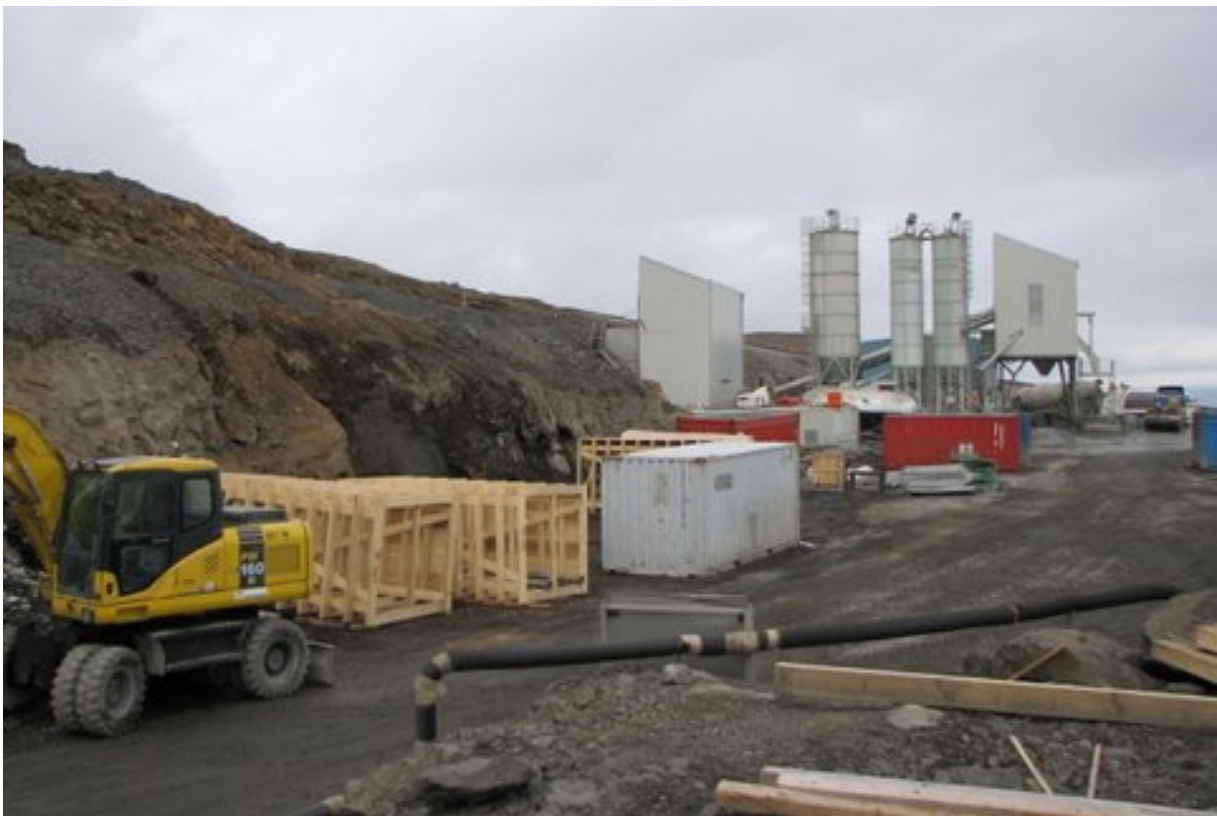
Steypstöð og hluti athafnasvæðis verktaka horft til norðurs.
