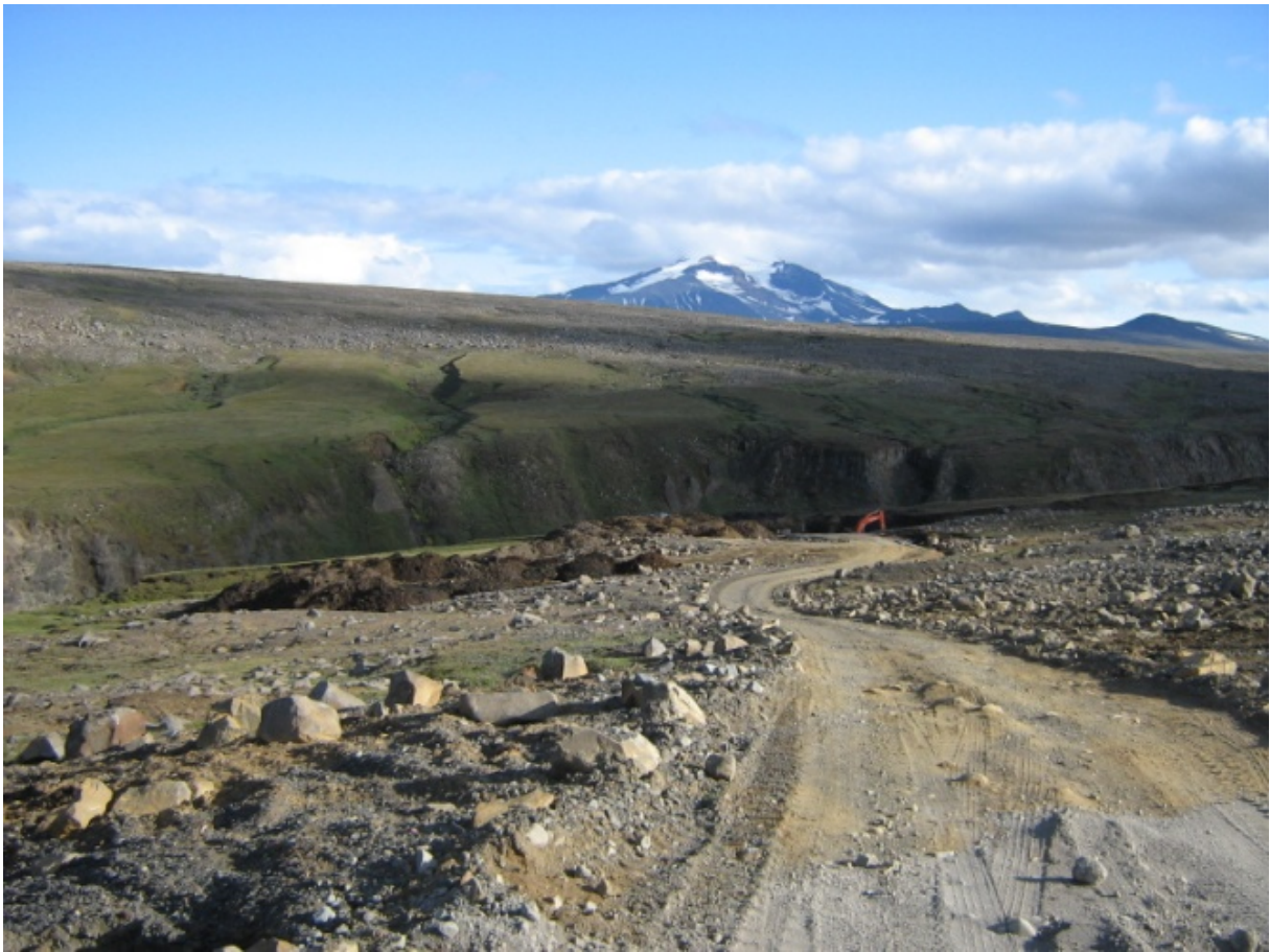
Búið að fjarlægja útbúnað og frágangur hafinn við plan. Grafinn var gryfja við planið til að koma þar fyrir aðfluttu efni og fá meira af moldarkenndum jarðvegi til frágangs. (13.07.2008)
