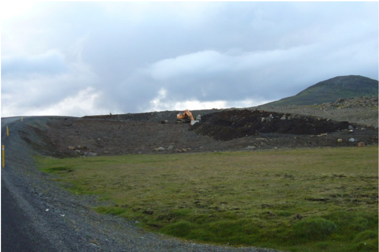
Náma sunnan Laugafells. Í þessa námu var flutt efni úr aflögðum vegum. Við frágang var dreift grjóti um námusvæðið í líkingu við grjótdreif á öröskuðu landi utan námunnar. Grasfræi var sáð í námuna. Vegur að loftunarholu 2 var lagður um námusvæðið. (12.08.2009)
