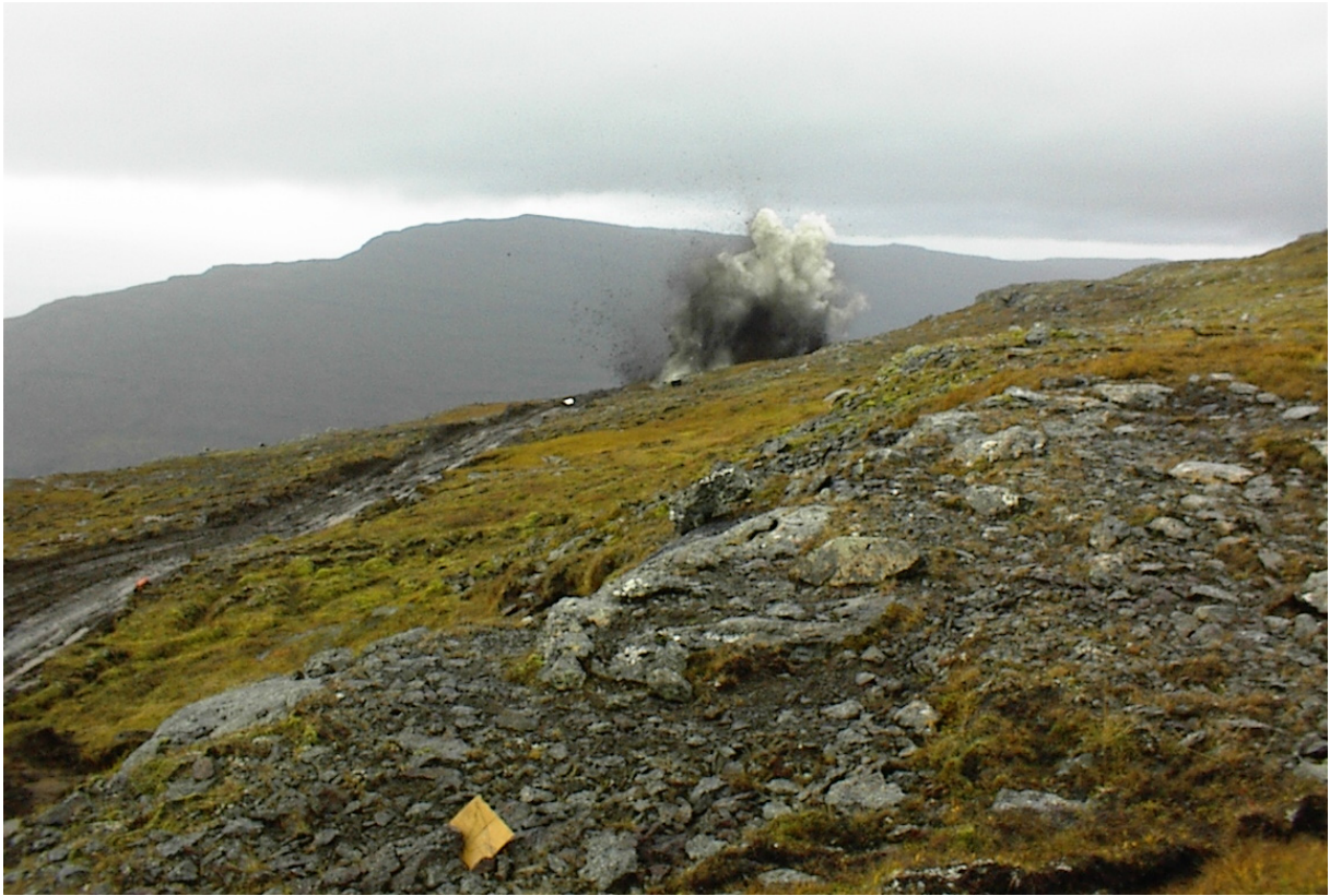
Upphaf framkvæmda við Aðkomugöng. Horft til suðurs.
