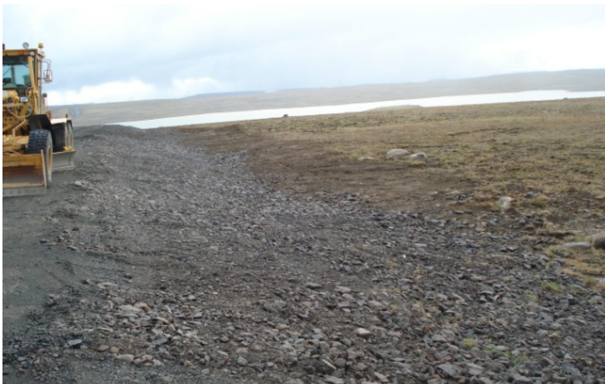
Mótun fláa og lands utan fláafótar lokið. (08.09.2009)
