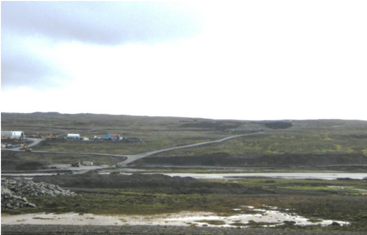
Aðstaða verktaka og náma austan Kelduárstíflu. Vegir og plön ofan lónborðs voru fjarlægð. Efninu var að hluta komið fyrir í námunni. (14.08.2008)
