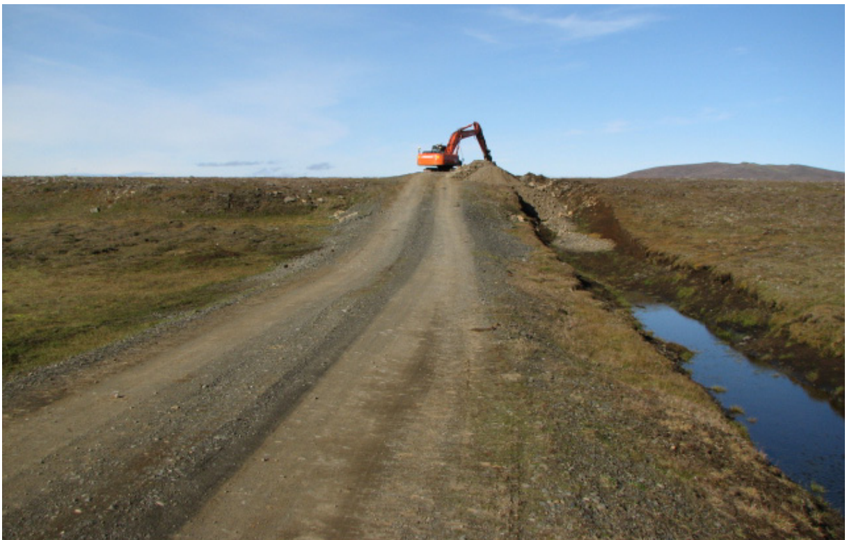
Við frágang vegarins var fyllingu mokað aftur í skurðinn. Umframefni var komið fyrir í gamalli gryfju við Fljótsdalheiðarveg. (10.09.2009)
