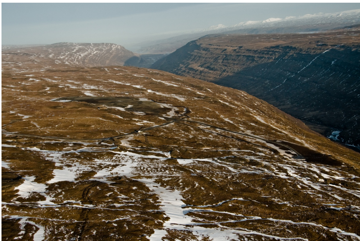
Haugsvæði og athafnasvæði við gangamunna. Landmótun lokið. Uppgræðsla ekki hafin. (05.11.2008)
