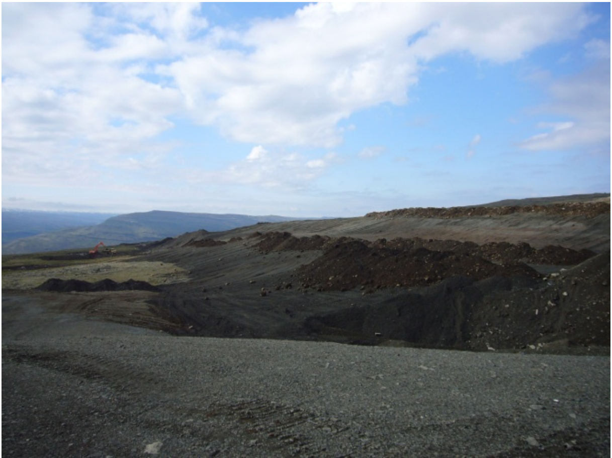
Lokið við af flytja jarðveg upp á frambrún haugsins. Við mótun haugsins var lögð áhersla á að form hans líktist sem mest landformum í næsta nágrenni. (26.06.2009)
