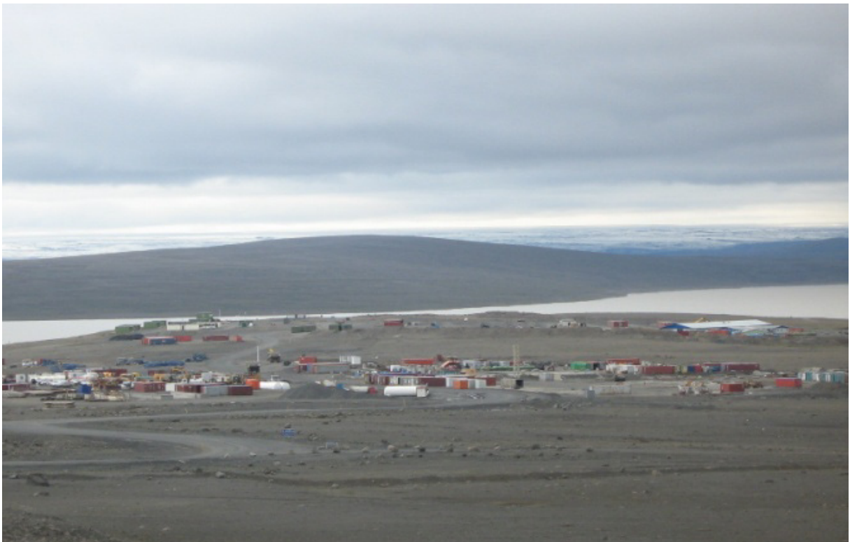
Búið að rífa skemma og hluta vinnubúða. Steyptar undirstöður voru fleygaðar í sundur og steypuúrgangur fluttur til urðunar í grjótnámu L2 norðan búðasvæðisins. (09.09.2009)
