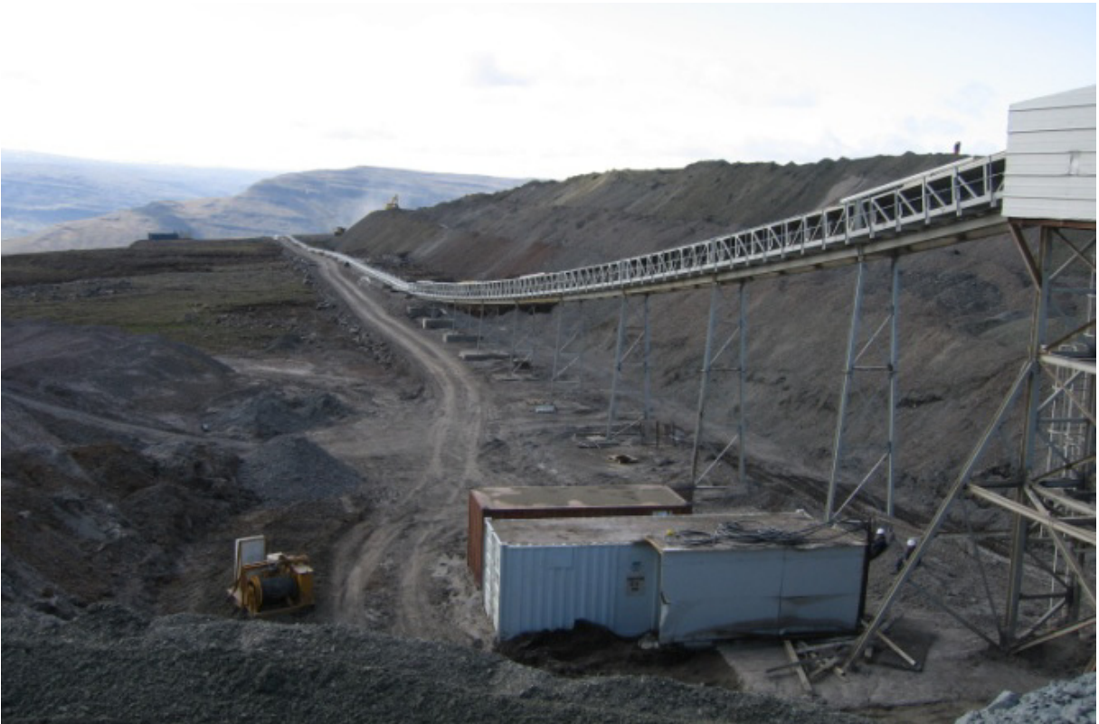
Færibönd fluttu efni frá jarðgöngum á haugsvæðið. (28.06.2006)
