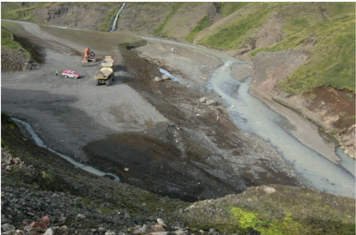
Búið er að fjarlægja steypta plötu og hluta plans í og við farveg Glúmsstaðadalársár. (18.08.2009)
