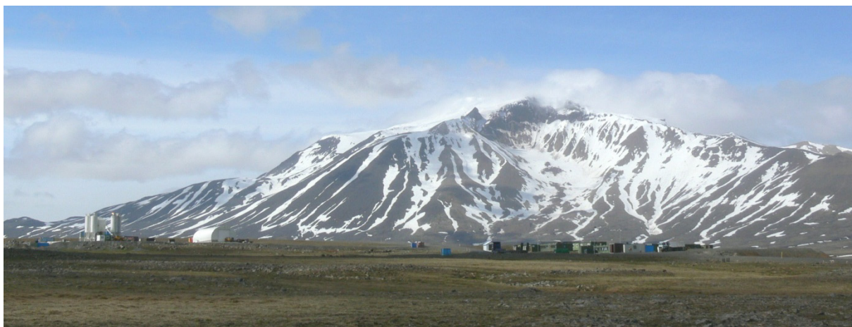
Yfirlitsmynd . Vinnubúðir og athafnasvæði verktaka við Ufsarstíflu. (13.06.2010)
