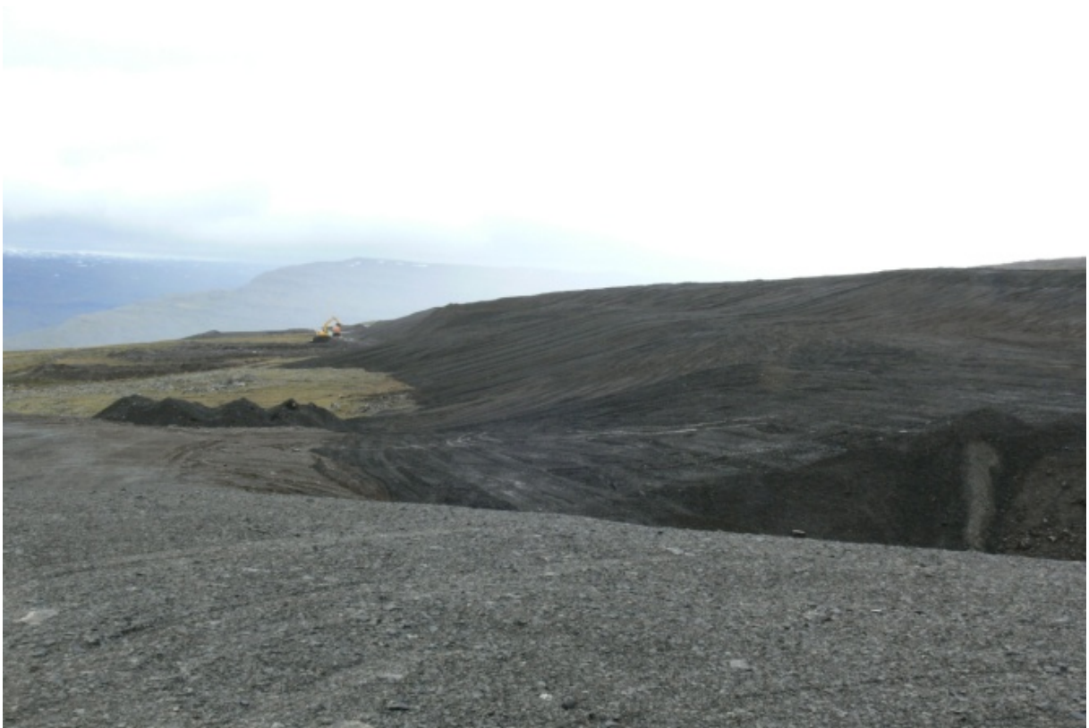
Nánast lokið við að ýta jarðvegi yfir frambrún haugsins. Lögð var áhersla á að dreifa grjóti um yfirborð hans í líkingu við grjótdreifar sem sjá má á öröskuðu landi nærri haugsvæðinu.(18.06.2009)
