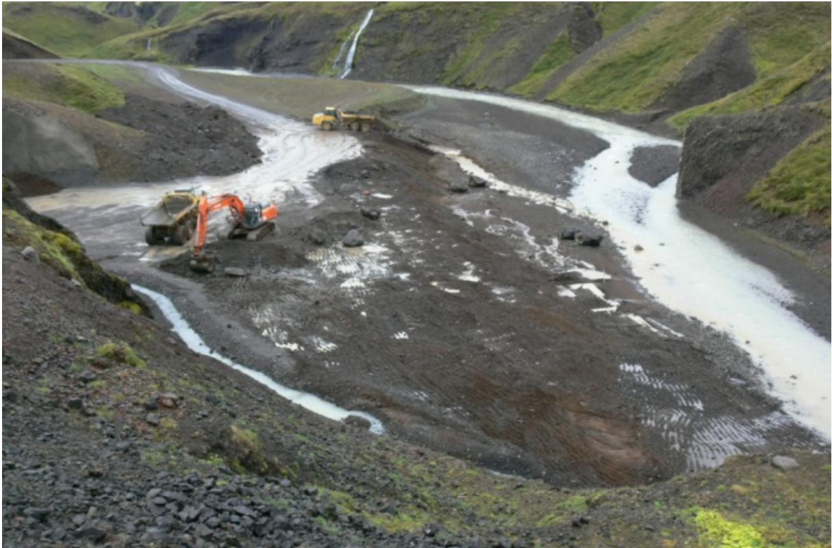
Efni var mokað ofan af lífrænum jarðvegi að þeim stað þar sem talið var að brekkurætur hafi verið áður en framkvæmdir hófust. Efni úr plani var að hluta til notað til að móta flatari brekku ofan við planið. (19.09.2009)
