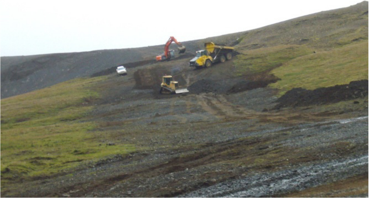
Unnið við að móta land að nýju. Umfræfni úr slóð nýttist að hluta til landmótunar við færíbandaslóðina. Lögð var áhersla á að móta að nýju vatnsrásir í brekkuna, en þær höfðu verið fylltar við framkvæmdir. (26.08.2009)
